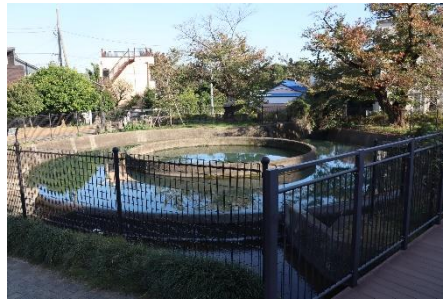
久地円筒分水
