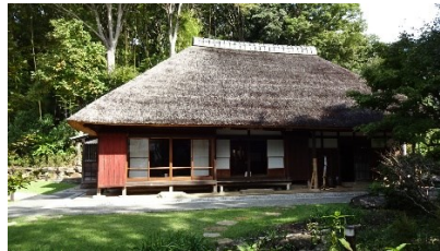
馬場花木園内の古民家
